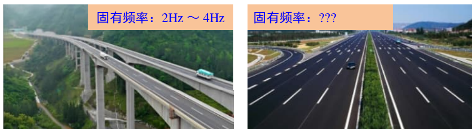
图 2 普通桥梁结构系统的固有频率
